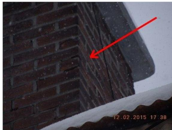
la détérioration des joint de maçonnerie ainsi que la brique indique des dommages internes plus importantes ou même l'absence de chemisage intérieur
