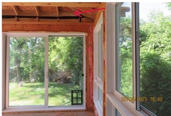
Travaux de finition non fini
