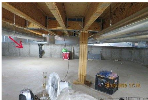
Fondation en béton - Mur non isolé
