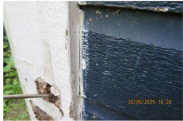
Déclin de bois - pourriture - Côté arrière
