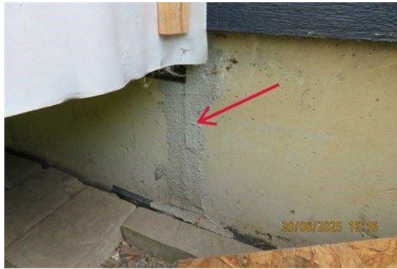
Fissures réparées - Côté arrière
