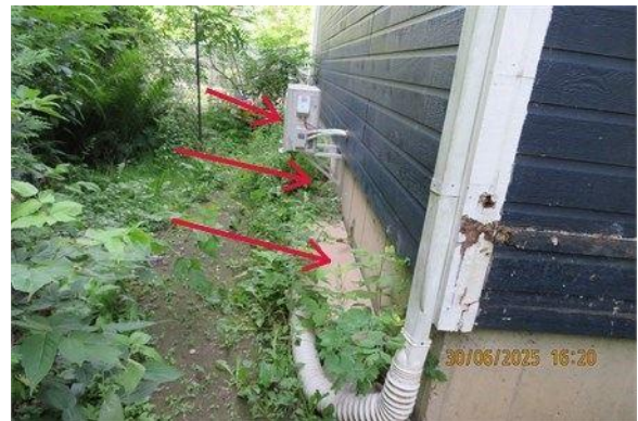
Drainage du terrain - Vers la maison à certains endroits
