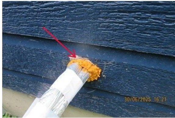
Ouverture scellée avec d'uréthane,
