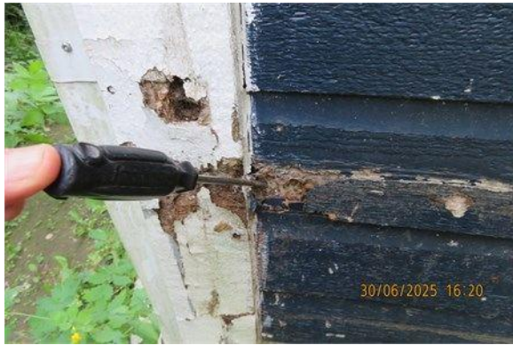
Déclin de bois - pourriture - Côté arrière
