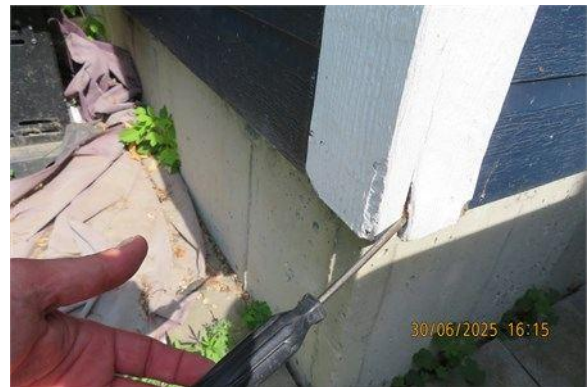
Déclin de bois - pourriture - Côté arrière
