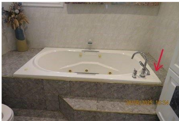
Contour de bain/douche - Joint de scellemen
