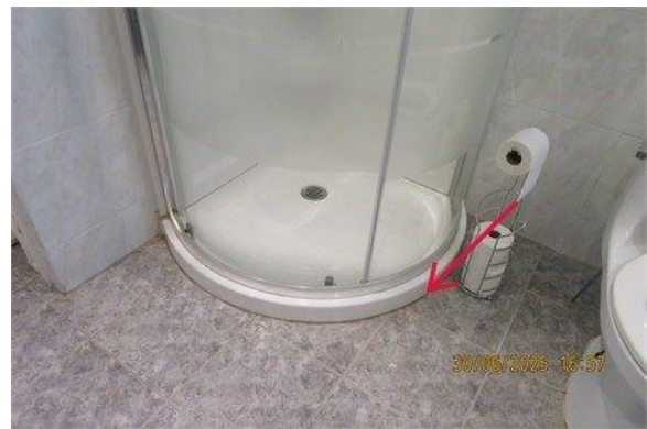
Contour de bain/douche - Joint de scellemen
