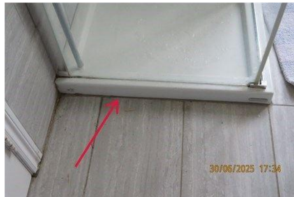
Contour de bain/douche - Joint de scellemen
